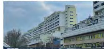
Abb. 4: Ansicht der Ostfassade
