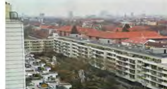
Abb. 3: Blick in den geschützten Zwischenraum mit Ansicht der Parabolbohle
