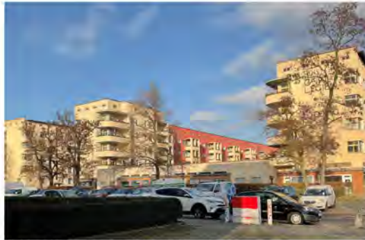
Abb. 1: Blick auf die Wohnstadt von Erch-Weinen-Strasse/ Gubitzstraße
